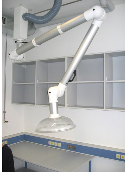
Punktabsaugung deckenbefestigt
