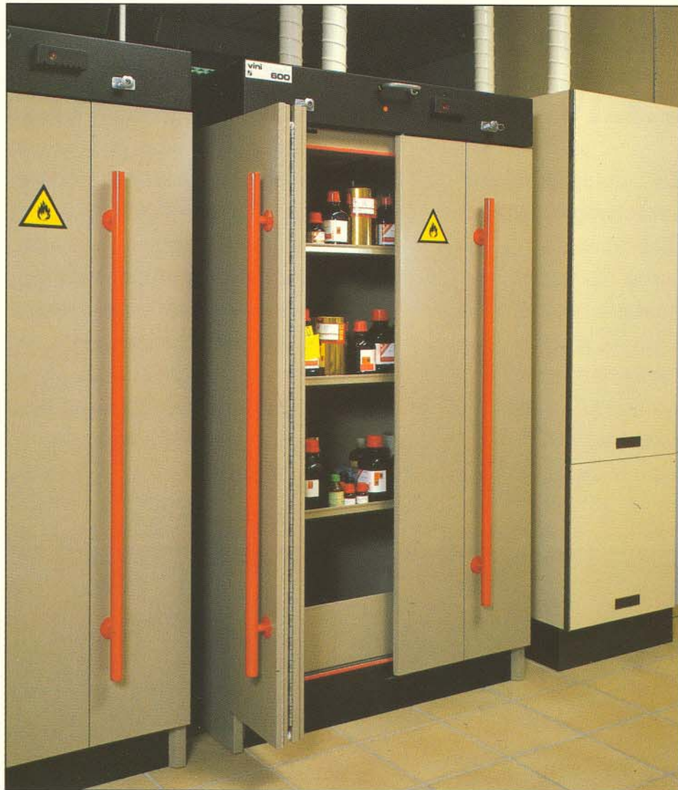
D.S.M. Geleen, Gebouw 93. Vinifiresafe en Vinitex loogkast voorzien van afzuiginstallatie.
