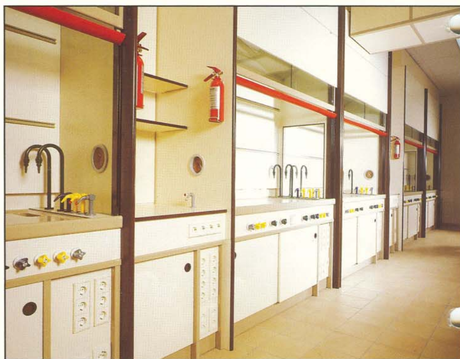
Apparatenkast geplaatst naast gekoppelde zuurkasten met separatie opening.
